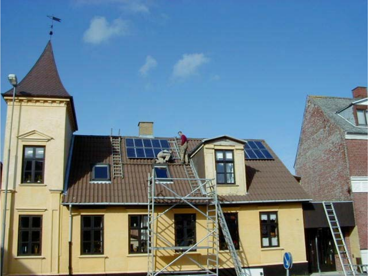
Figur B1.3: Montering af solceller på ejendom
